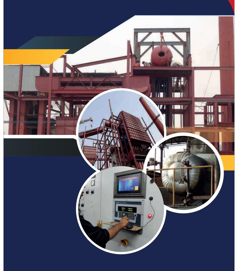
30TPH, 35BARG, 350°C DOUBLE DRUM, CHAIN GRATE, BAGASSE AND COAL FIRED BOILER ISLAND FOR SARENA TEXTILE MILLS
